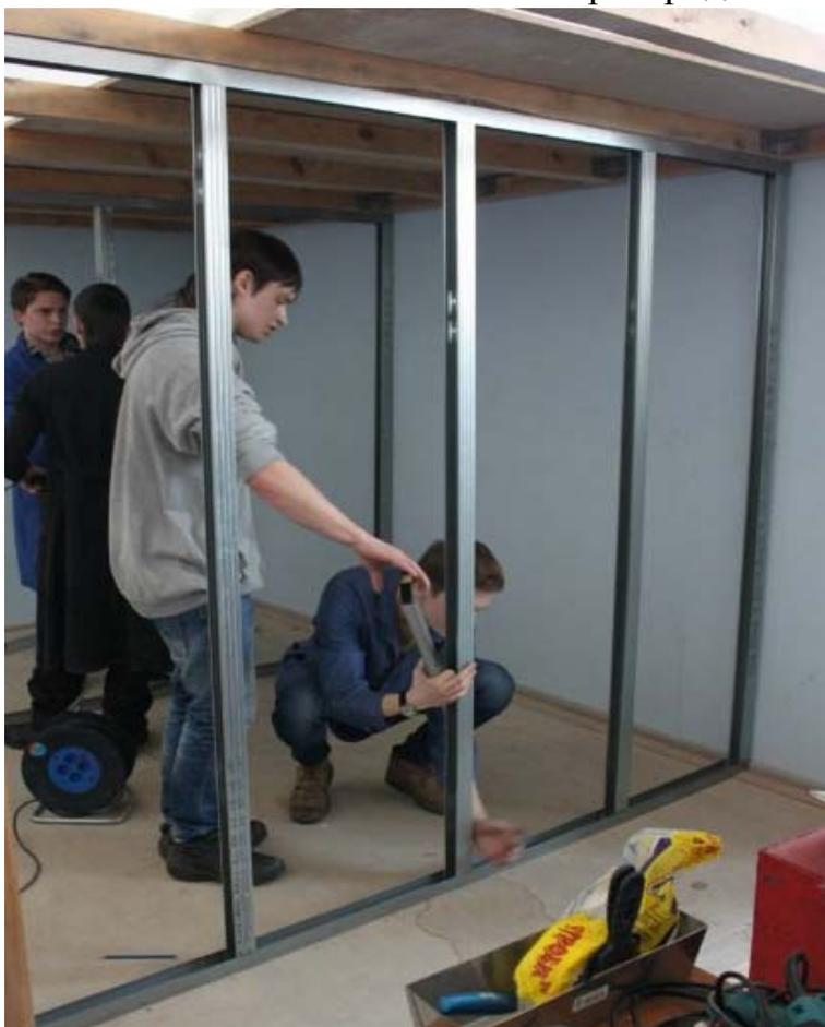
*Рис.1. Монтаж металлического каркаса*
