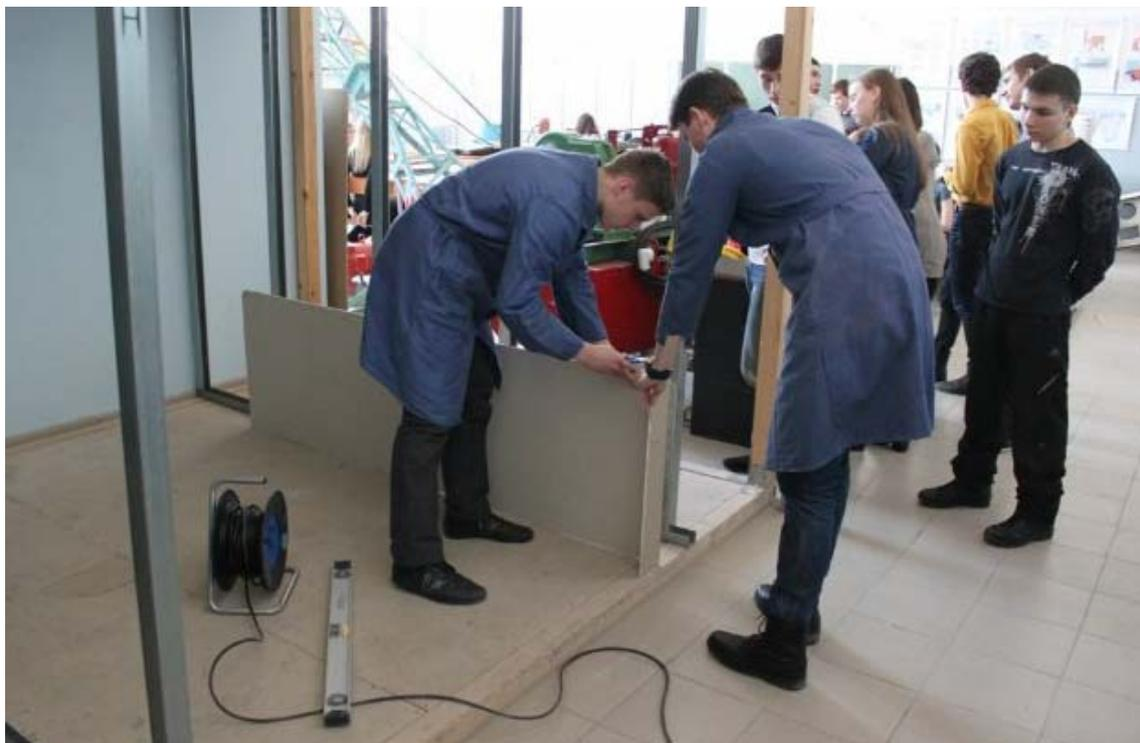
*Рис. 2. Обшивка каркаса гипсокартонными листами*
