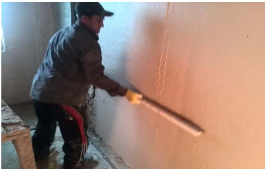
*Рис. 5. Разравнивание штукатурного слоя трапециевидным правилом.*
