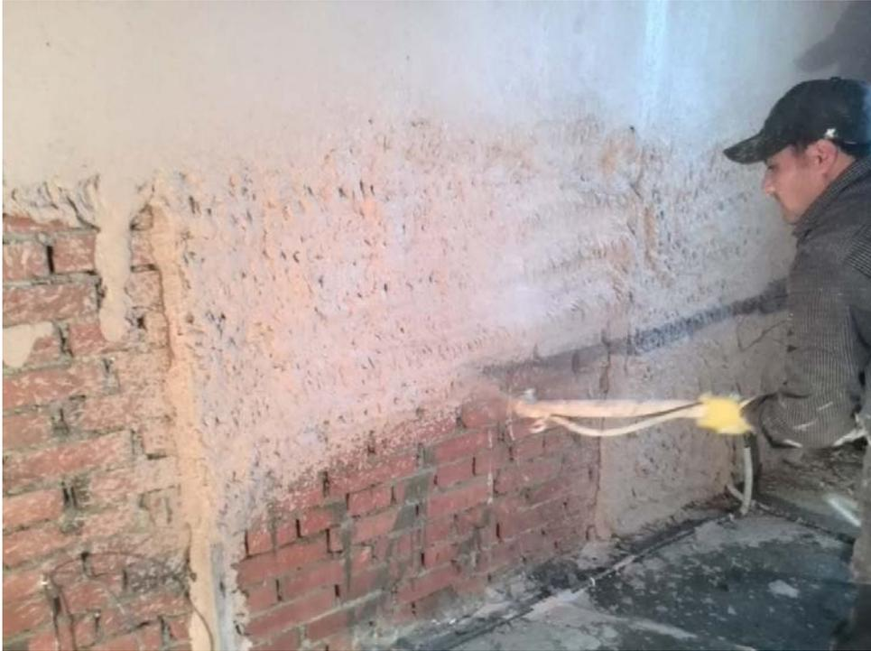
*Рис. 4. Нанесение штукатурного состава*
