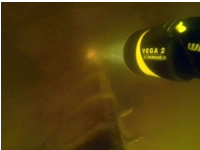
Рис. 2 - Русло вокруг опоры №3. Посторонние конструкции
