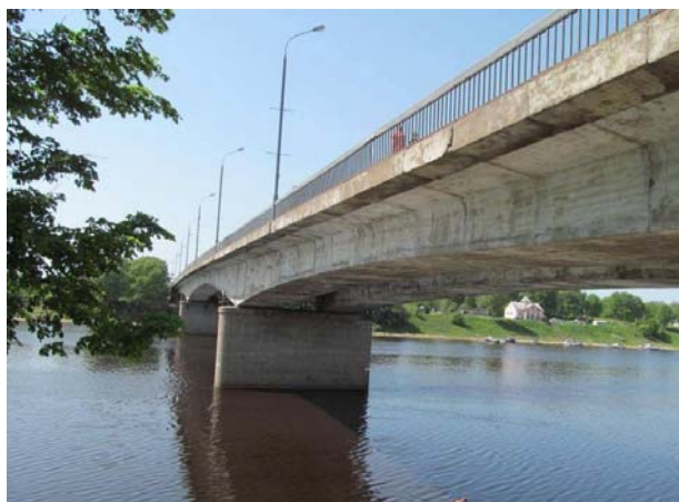
Рис. 1 - Общий вид моста от опоры №0 с левой стороны
