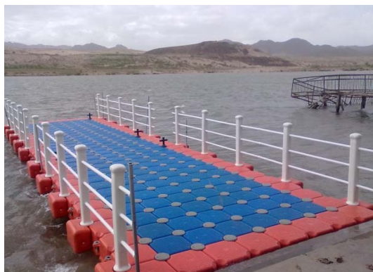
Рис. 1- Понтонные сооружения из поплавков
