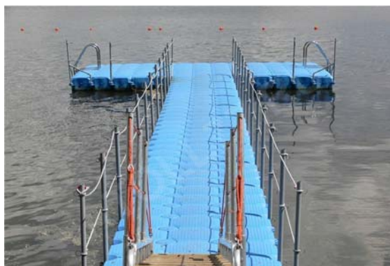
Рис. 1- Понтонные сооружения из поплавков
